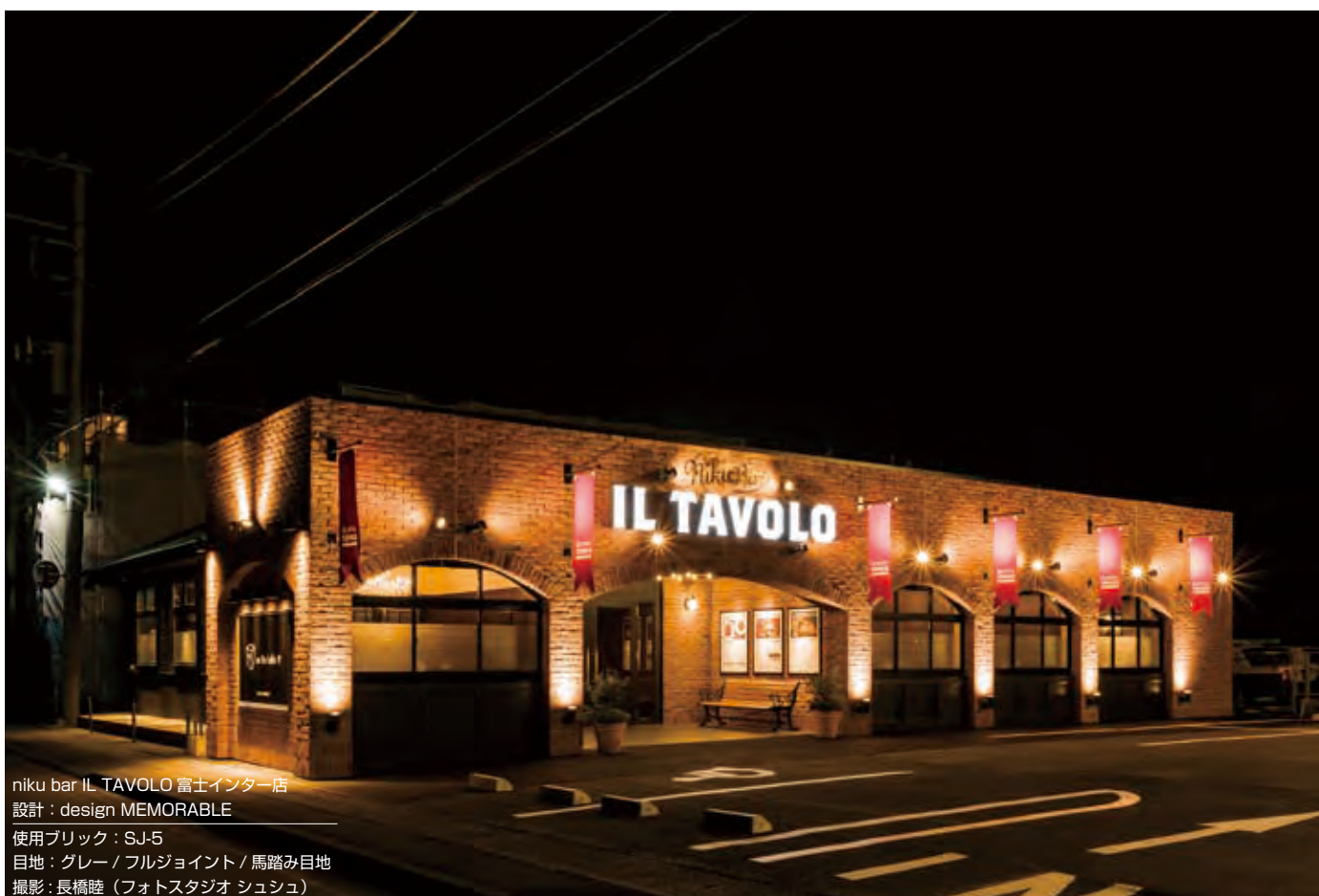
niku bar IL TAVOLO 呉服町店 設計 : design MEMORABLE 使用ブリック : SJ-5 目地 : グレー / フルジョイント / 馬踏み目地 撮影 : 長橋睦 (フォトスタジオ シュシュ)
