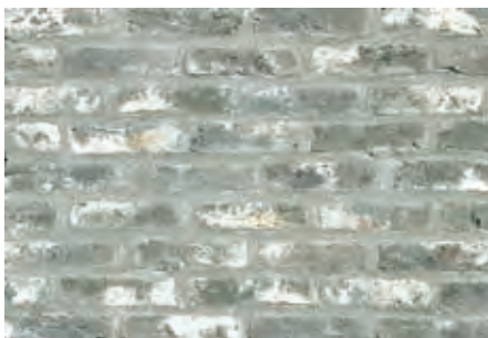
AM-2 目地色：グレー / 目地仕上げ：オーバークラウトジョイント / 目地パターン：馬踏み目地
