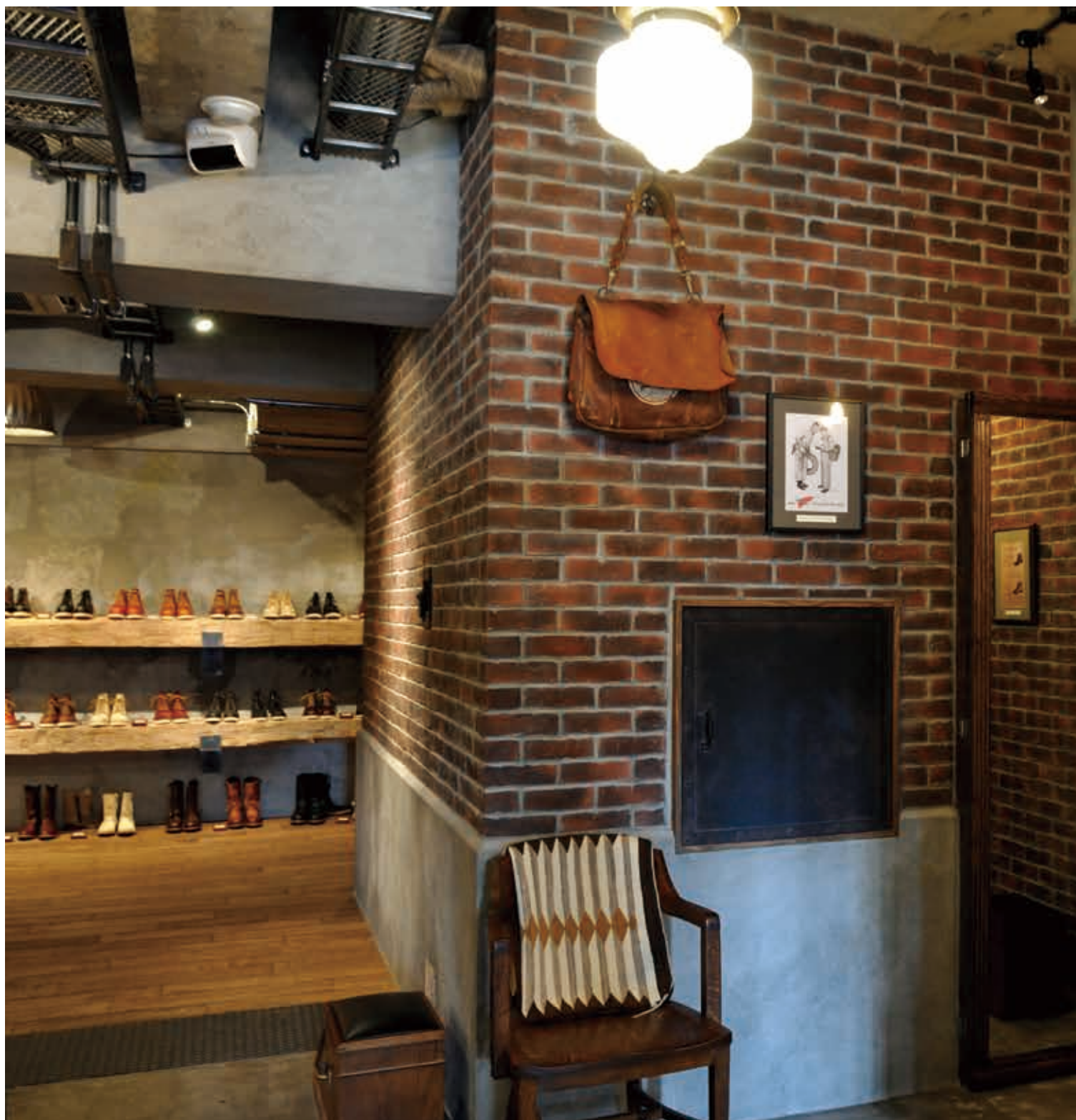
RED WING SHOE STORE 東京青山店 設計：株式会社ハイライト 使用ブリック：STD-30 目地：グレー／フルジョイント／馬蹄目地
