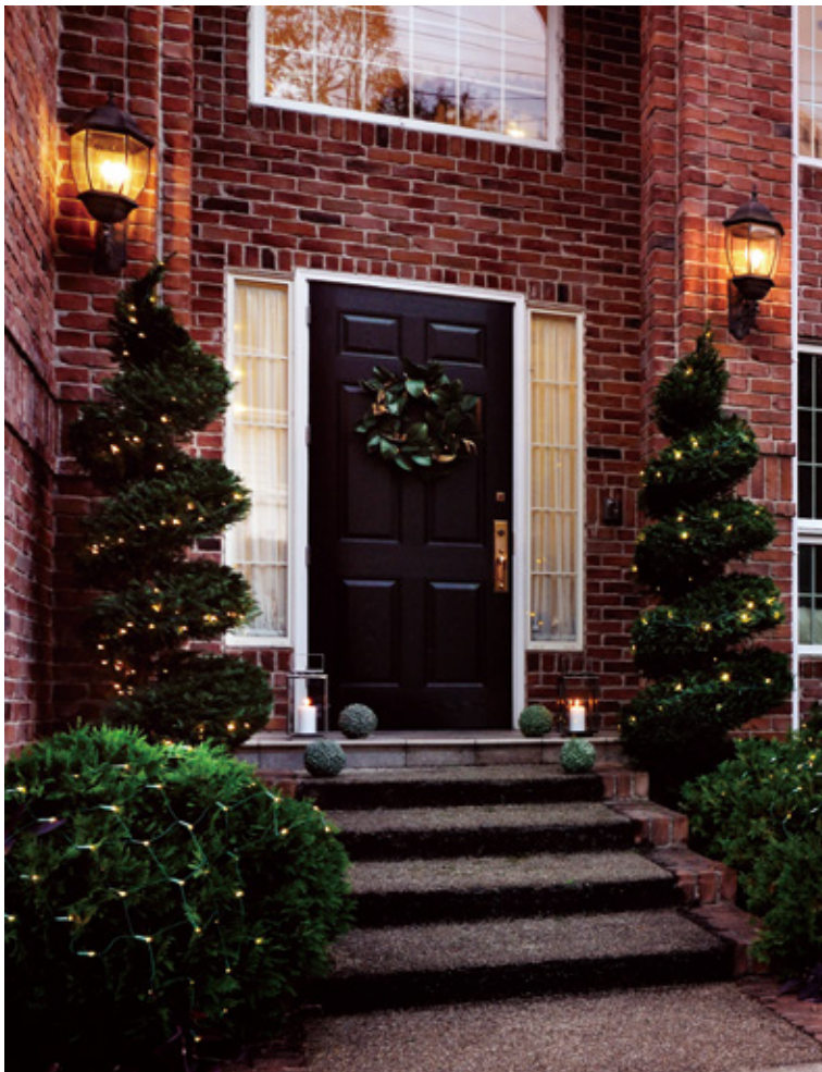
照明: 2422-BK / 外壁: CAN'BRICK「ケンブリッジ(CB-3)」
