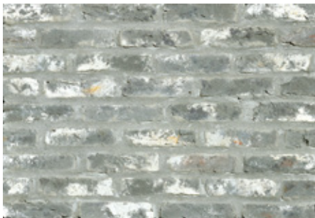
AM-2 目地色：グレー/目地仕上げ：オーバークラウトジョイント/目地パターン：馬蹄み目地
