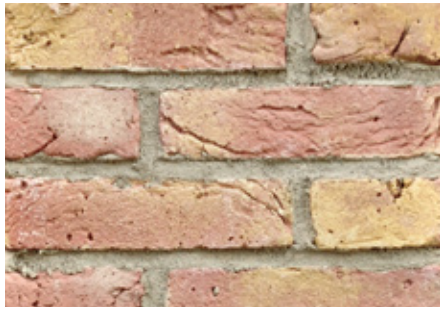
フルジョイント (Full Joint)
