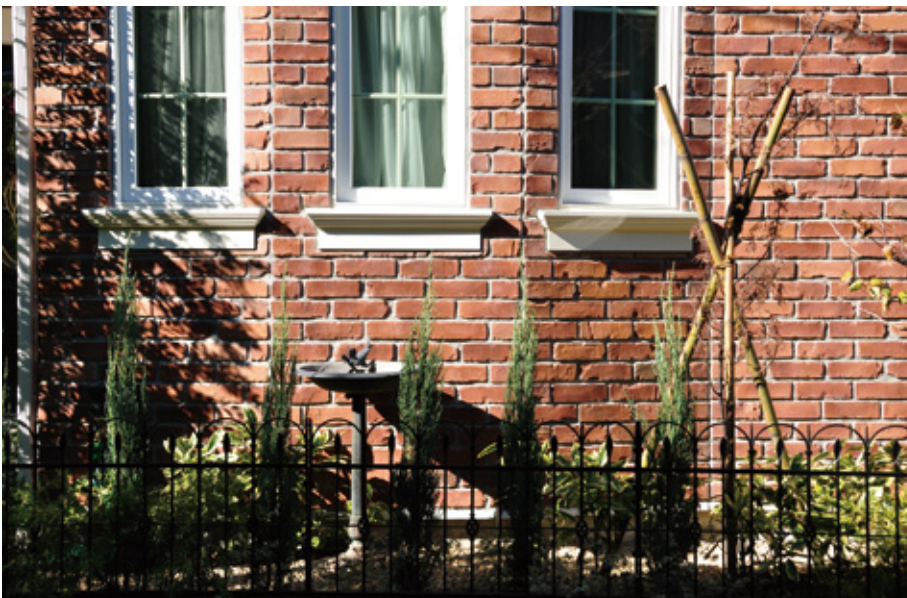
CB-2 目地色：オフホワイト / 目地仕上げ：フルジョイント 目地パターン：フランス張り
