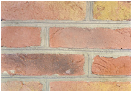
グレーバインジョイント (Grapevine Joint)
